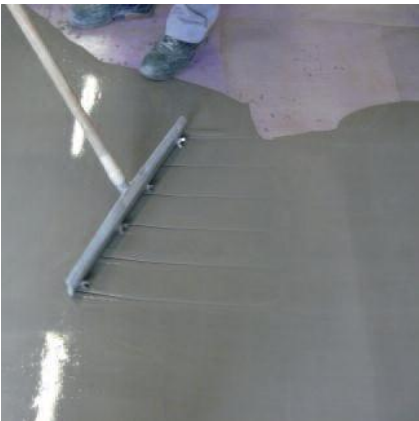
PCI ZEMTEC 230 met een stiftrakel of trapeziumgetand spackmes verdelen.
