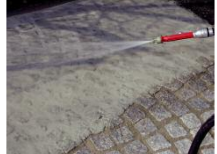
Om bij het reinigen van de bestrating te voorkomen dat de voegen uitspoelen, de waterstraal bijna horizontaal aan het oppervlak houden.
