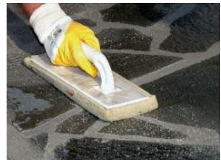
Binnen een uur de platen met een sponsbord nawassen.
