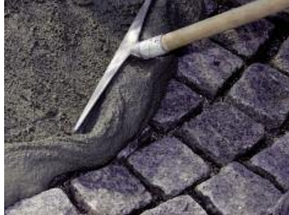
Bij inslemmen kan PCI PAVIFIX CEM met een rubberwisser gemakkelijk in de voegen worden gewerkt.
