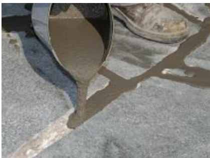
PCI PAVIFIX CEM in de voegen gieten.
