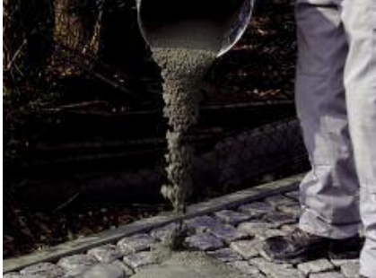
Aanbrengen van PCI PAVIFIX CEM op het oppervlak.
