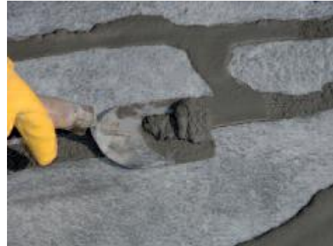
Na het aantrekken van de mortel (vingertoppentest) overtollig materiaal met een troffel weghalen.
