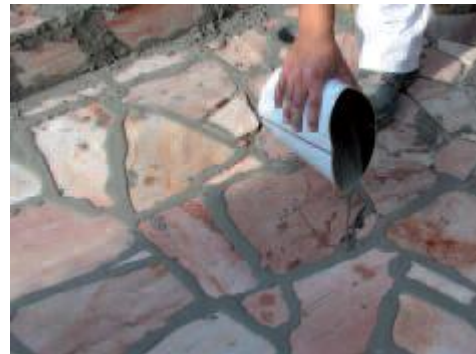
PAVIFIX CEM RAPID in de voorbereide voegen gieten.
